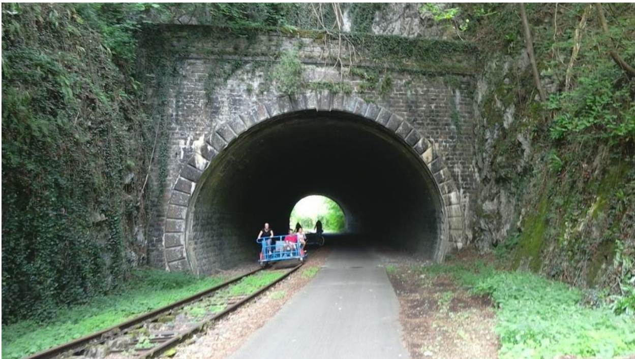
Rycina 53. RAVeL L150, z zachowanym jednym torem dla rowerów szynowych.
