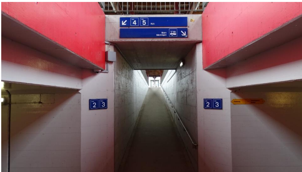
Rycina 47. Prosto biegnące rampy zapewniają bardziej niezawodny i wydajny dostęp do platform niż windy. Stein-Säckingen, Szwajcaria.
