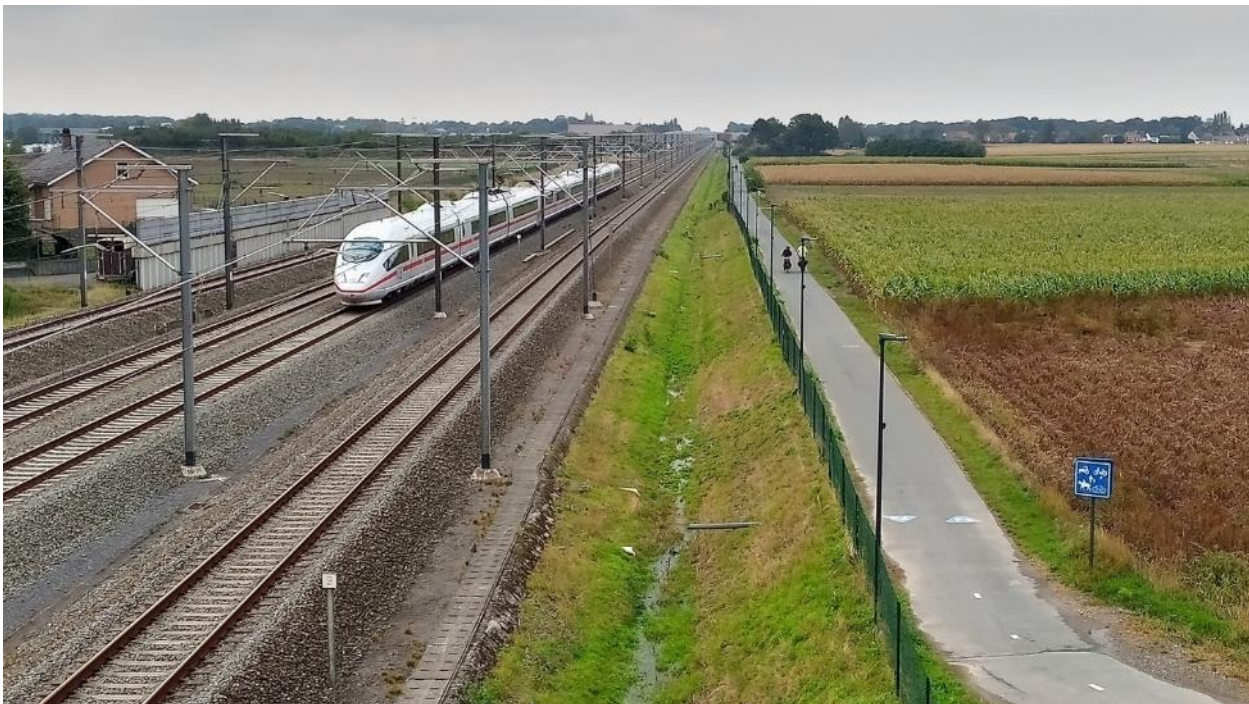
Rycina 40. Autostrada rowerowa F3 biegnie przez większą część trasy między Leuven a Brukselą wzdłuż szybkobieżnych linii kolejowych.
