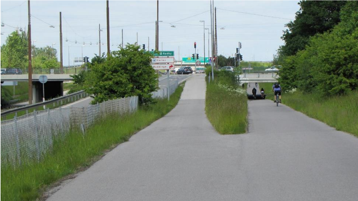
Rycina 42. Drogi rowerowe wzdłuż autostrady zintegrowane ze skrzyżowaniami drogowymi. Trasa Farum, Region Øresund.
