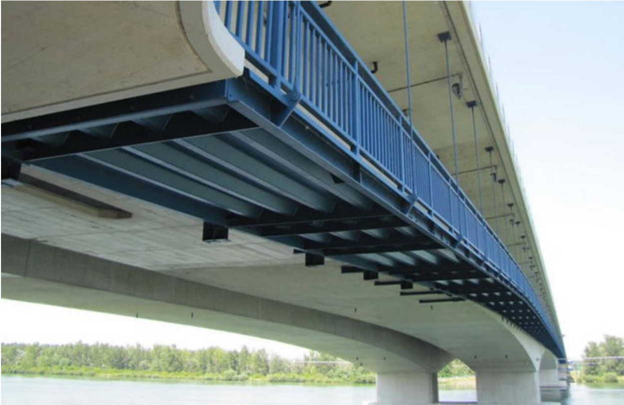
Rycina 44. Droga rowerowa na dolnym poziomie mostu drogi ekspresowej S33 nad Dunajem, Austria.
