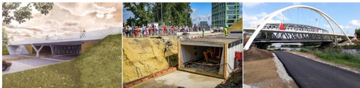
Rycina 61. Planowanie inwestycji (1), trasa w budowie (2) i most gotowy na powitanie rowerzystów (3).
