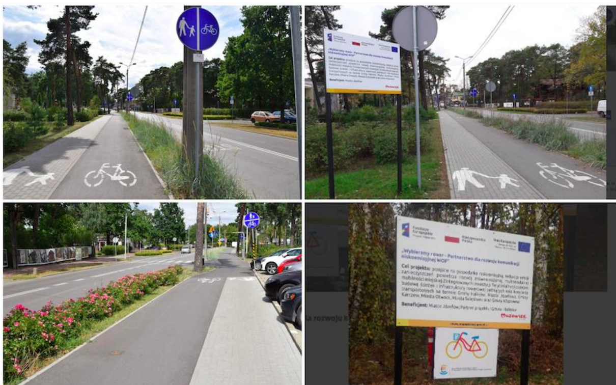
Rycina 60. Ścieżki rowerowe zbudowane w Józefowie, w południowo-wschodniej części metropolii.
